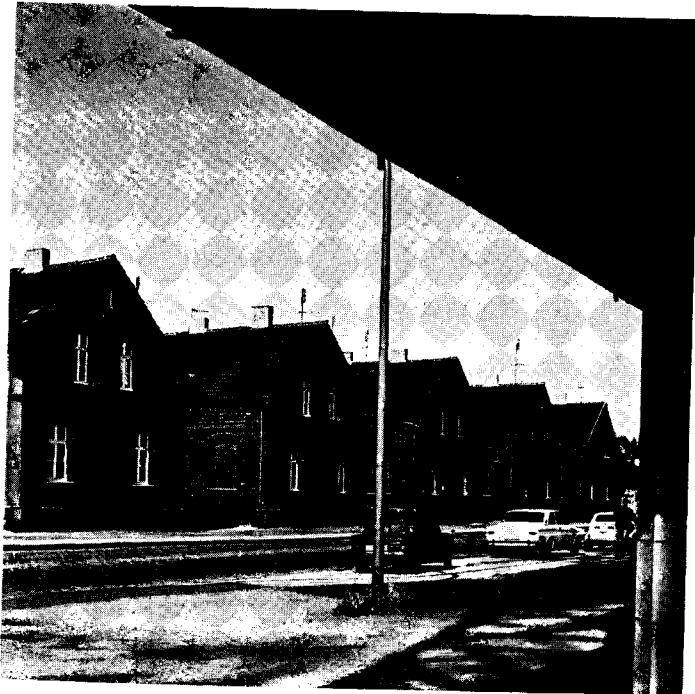
Werkwohnungen für Stahlarbeiter in Dinslaken an der Hünxer Straße aus den Jahren 1904/06
