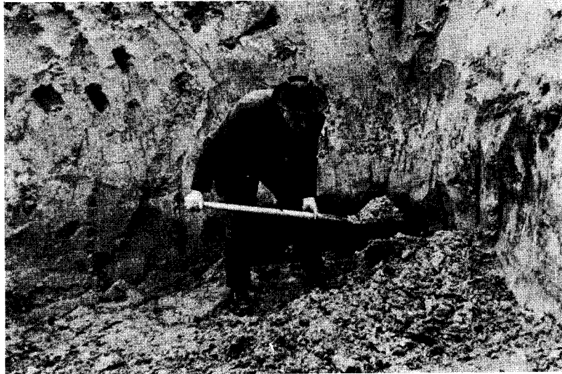
Freilegung des Schachtes in der Baugrube Liebermannstraße 2
