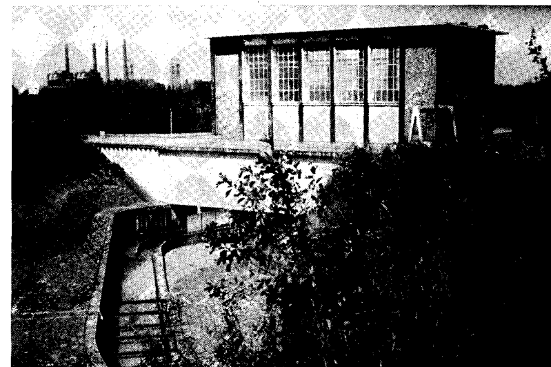
Der Einlauf der Kleinen Emscher in das Pumpwerk an der Schulstraße in Walsum. Im Hintergrund die Schachtanlage Walsum.
