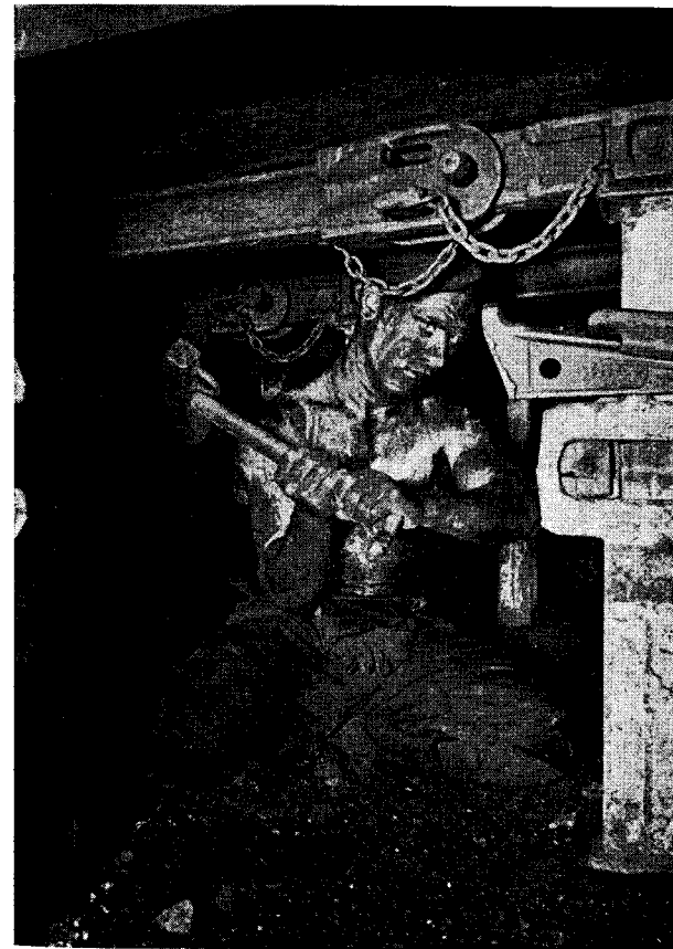
Einbringen des Strebausbaues
