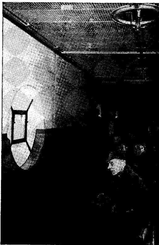
Im Mannschaftsbrückengang wurde eine Elektro - Aerosol - Anlage eingerrichtet
