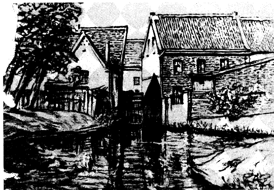
Der gestaute Rotbach am Walsumer Tor (um 1850), heute steht hier das Hochhaus
