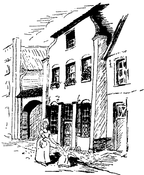
Das Haus des Dietrich Adam Grube in der Duisburger Straße
