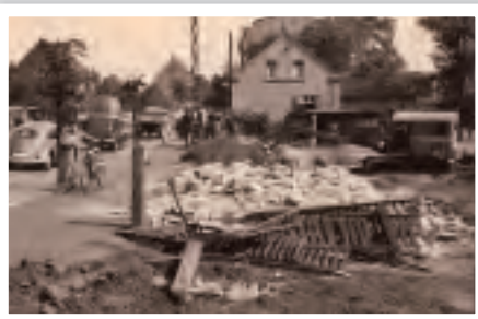
Der Abbruch der dort stehenden Häuser. In diesem Fall, der Verkaufsladen der Gärtnerei Möhlenkamp
