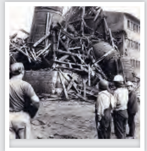
Sprengung des Laugenturms 1970
