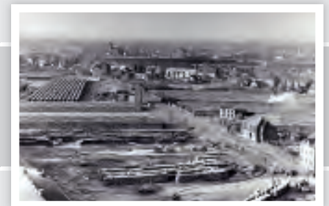
Das Holzlager der Zellstoff-Fabrik im Jahre 1958
