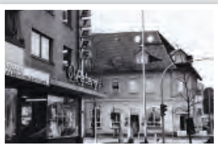
Friedrich-Ebert-Straße /Ecke Bahnhofstraße im Jahre 1988
