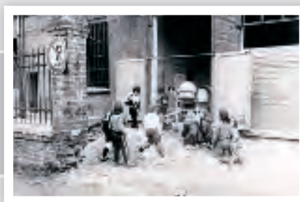
Das Jugendheim „Alte Schmiede“, wird gebaut.
