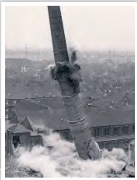
Auch der Kamin wird gesprengt.
