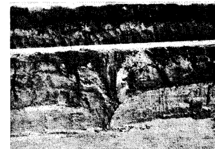
Abb. 7 Frostkeilartige Erscheinung in der Baugrube des Absetzbeckens der Kläranlage der Stadt Dinslaken. (Der weiße Querstrich ist ein Holzbalken)
