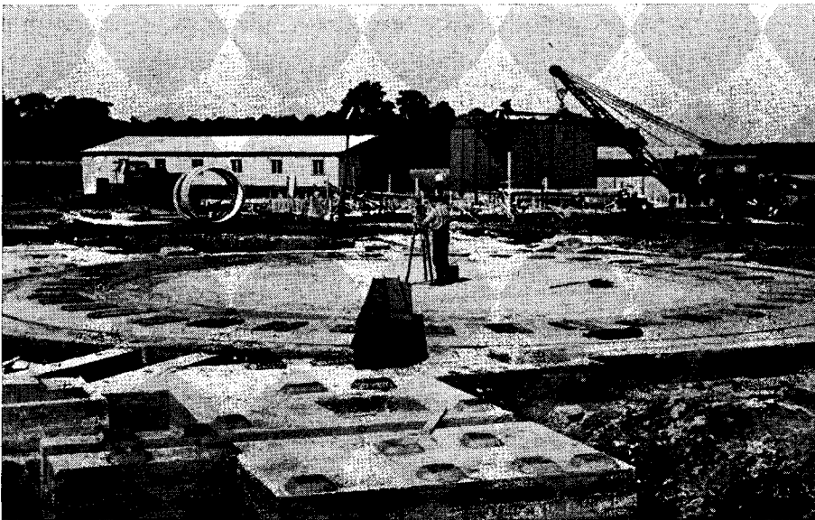
Abb. 5 Das fertige Fundament. Auf dem Schachtmittelpunkt steht das Meßgerät. Die Ansatzpunkte für die Bohrlöcher sind mit Holz abgedeckt.
