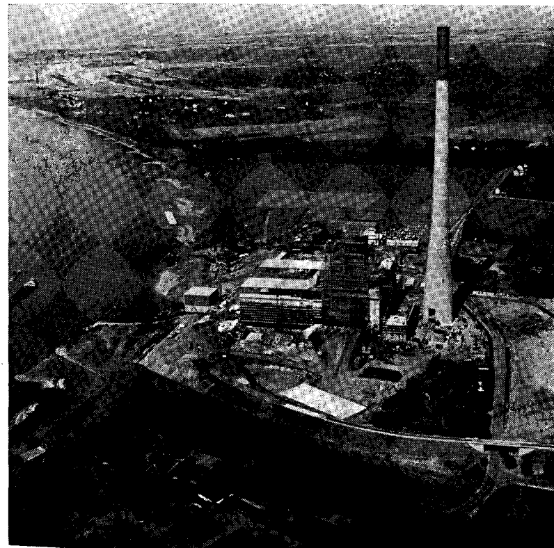
Gemeinschaftskraftwerk West, Möllen, 2 x 350 MW (Freigabe Nr. 3536/69 Reg.-Präsident Münster)
